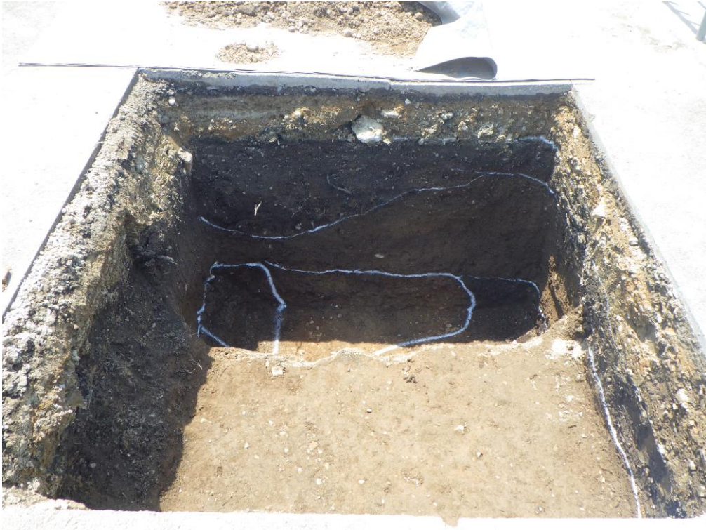
3. 南 2 トレンチ掘削状況(北から)
