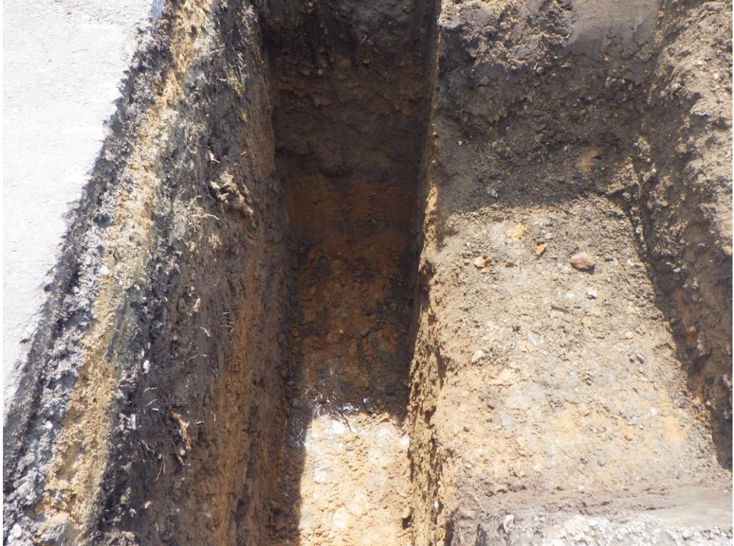
3. 南 1 トレンチ掘削状況(南から)
