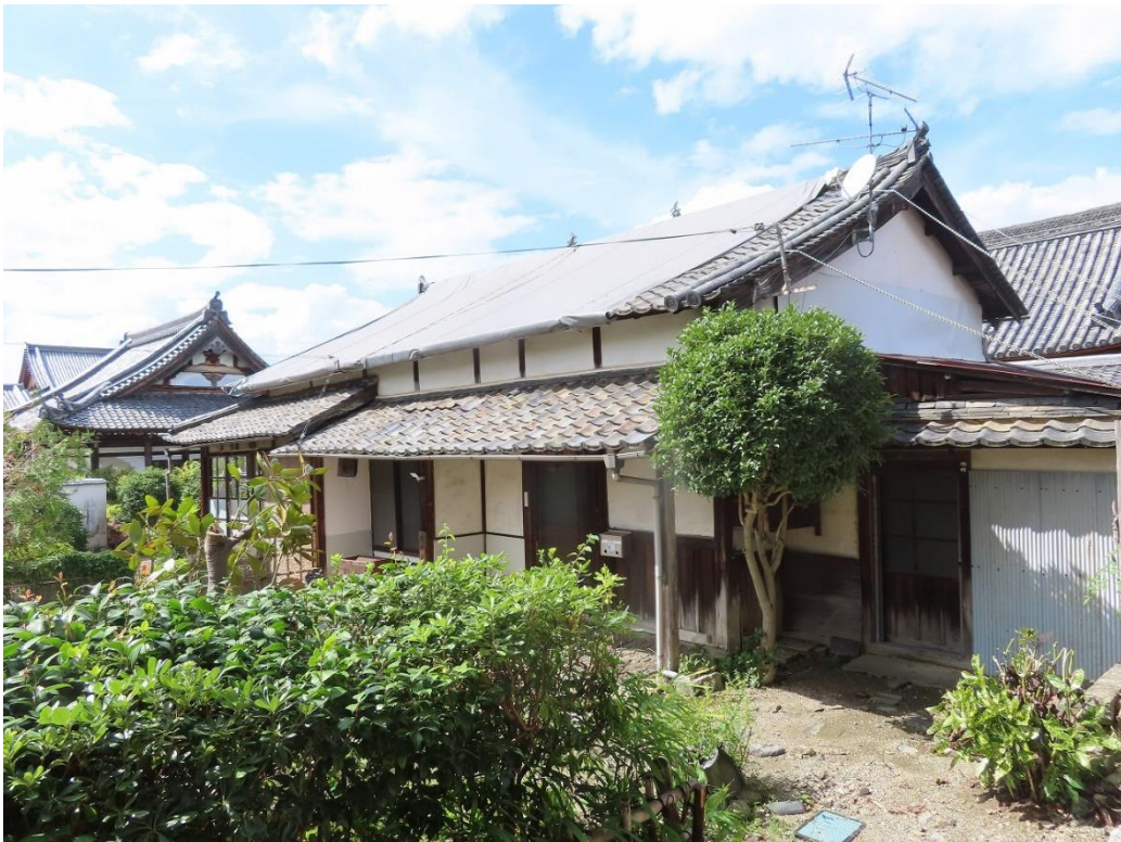
調査予定地（南東から）
