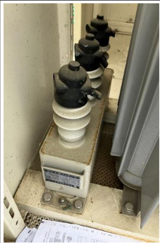
別紙 2 廃棄物保管状況及び周辺写真 平盛小学校②
